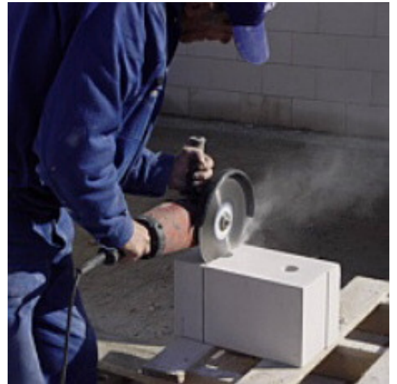
19 pav. Bloko pjaustymas diskiniu pjūklui.
