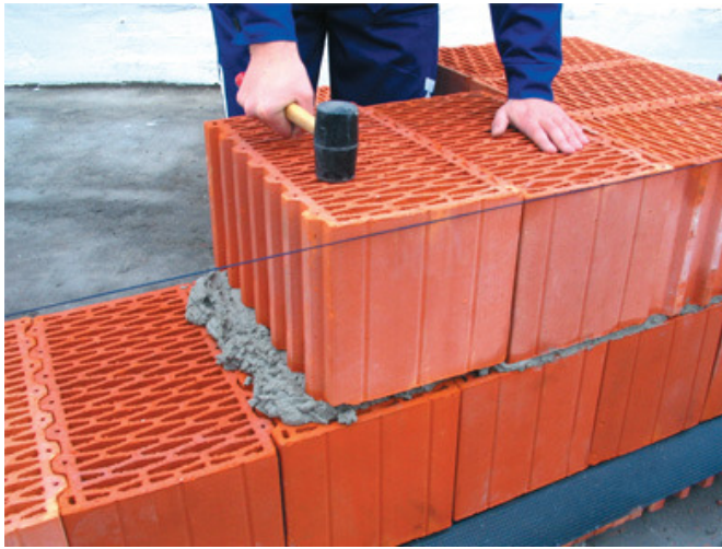
9 pav. Blokelių lyginimas guminiu plaktuku
