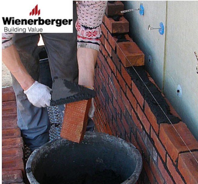
58 pav. Apdailinių plytų eilių mūrijimas pagal įtemptą virvę.
