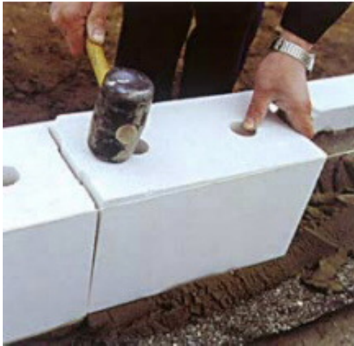
14 pav. Blokai išlyginami guminiu plaktuku.
