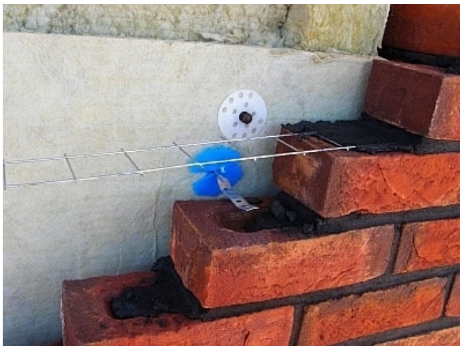
61 pav. Armavimas.
