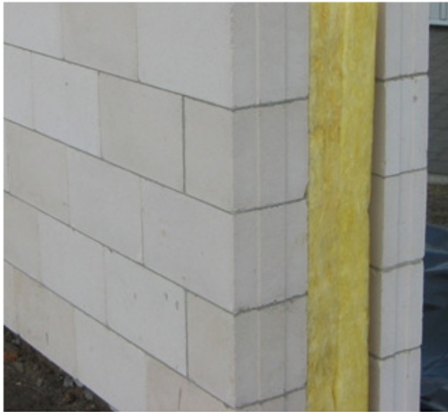
3 pav. Trisluoksnės mūro sienos konstrukcija
