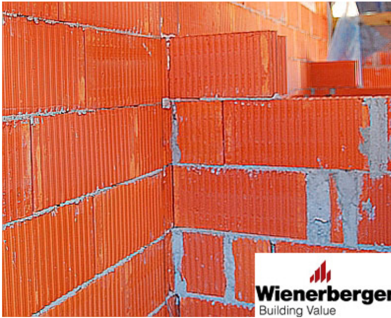
23 pav. Išorinės ir vidinės sienų sujungimas
