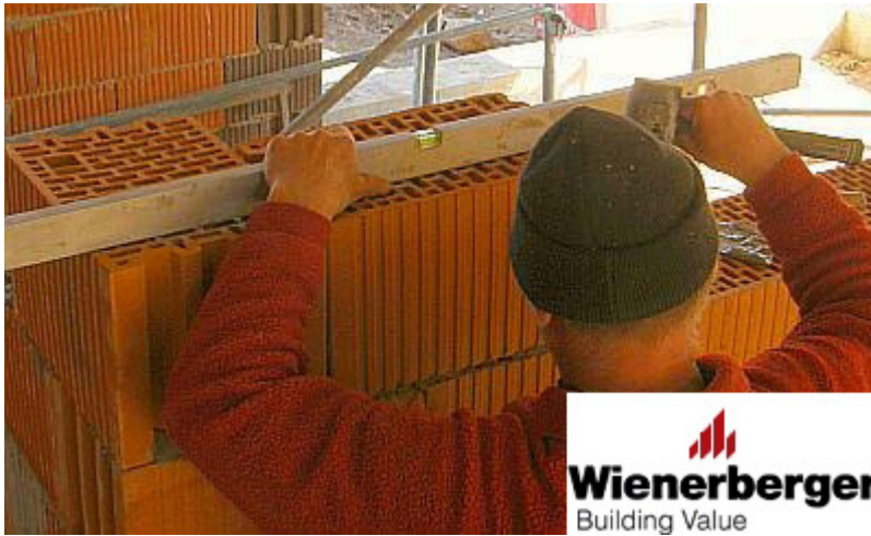
17 pav. Eilės horizontalumo tikrinimas
