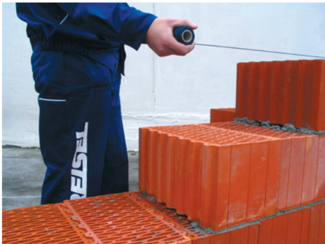
6 pav. Statybinės virvės ištempimas
