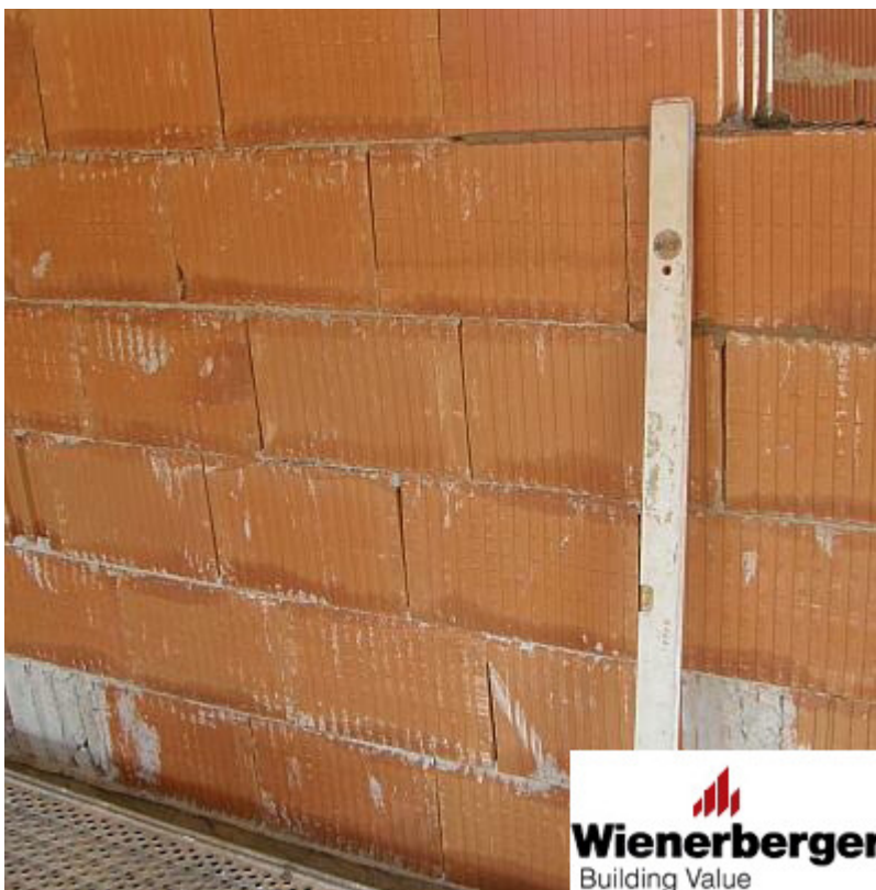
18 pav. Sumūrijus eiles, gulsčiu tikiama vertikalumas
