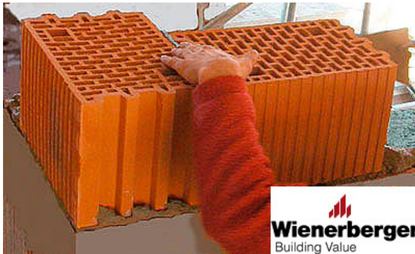
10 pav. Kampo mūrijimas, naudojant tik vientisus blokus
