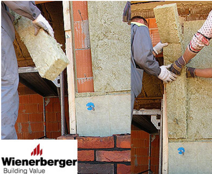
51 pav. Norint glaudžiai užpildyti karkaso ertmę, klojama pjaustyta plokštė
