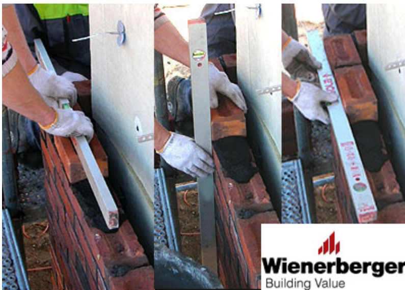
43 pav. Vertikalumo ir horizontalumo tikrinimas gulsčiu
