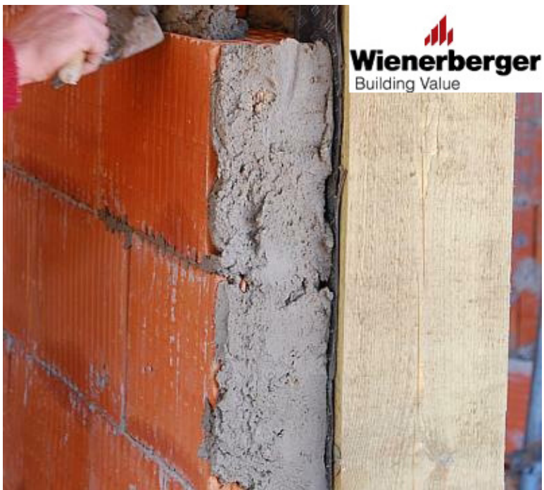
28 pav. Skiediniu dengimas ir vertikalias išpjaustytos bloko sujungimo vietas
