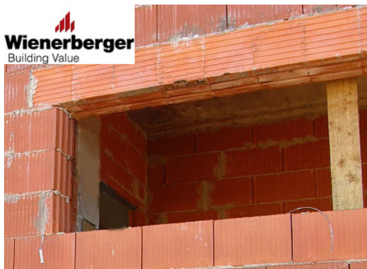
30 pav. Langų perdengimas sąramomis
