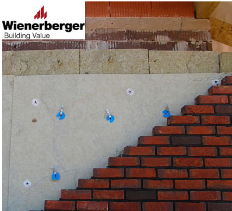
49 pav. Trisluoksnio mūro apšiltinimo sprendimai
