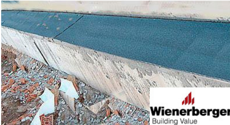
6 pav. Horizontali hidroizoliacinė danga
