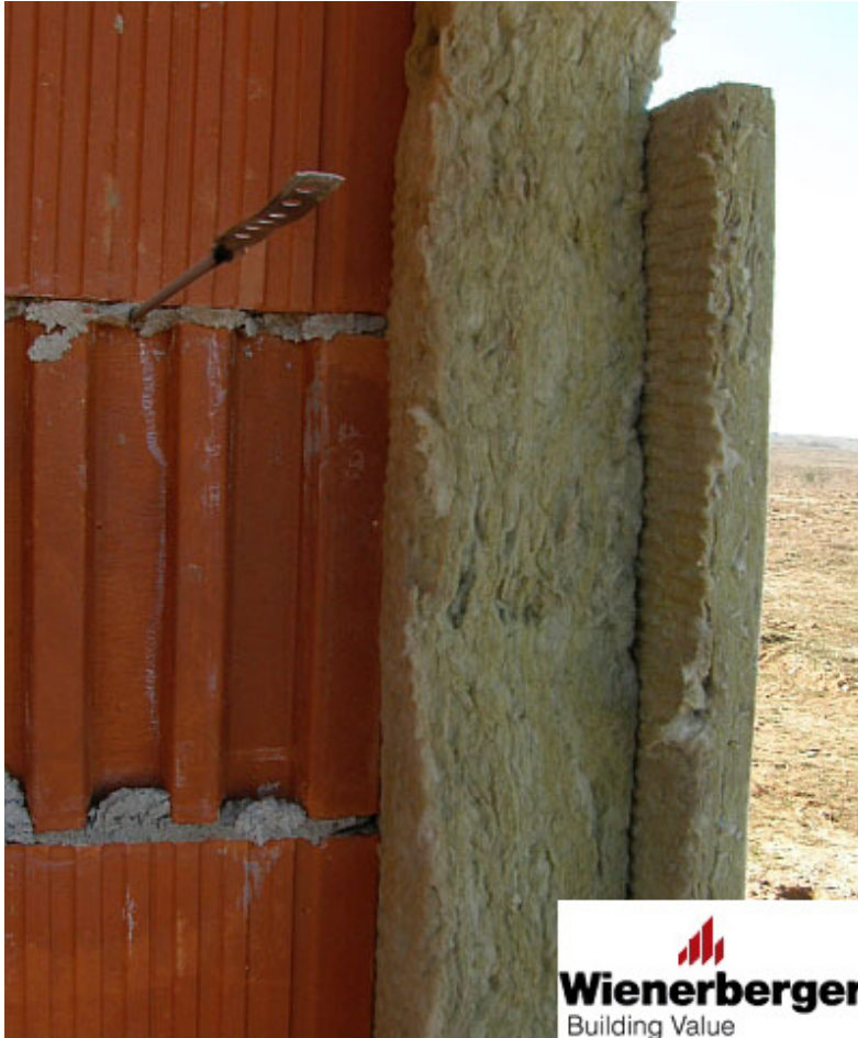
48 pav. Minkšta akmens vatos plokštė ir ją dengianti vėjo izoliacinė vatos plokštė kiaurai uždedamos ant kyšančių iš bloku mūrinio metalinių ryšių ir laikosi ant jų
