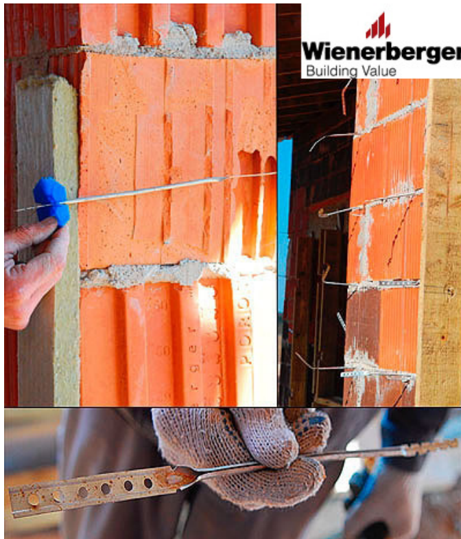
20 pav. Metalinių ryšių įmontavimas į horizontalias mūro siūles
