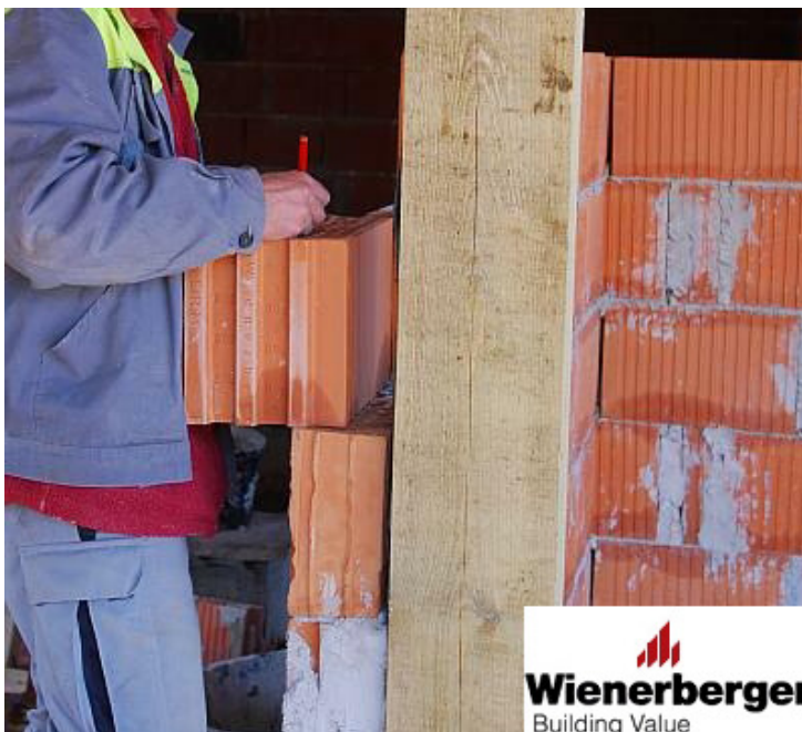
24 pav. Išpjaustymui skirtos bloko dalies dydžiai matuojami ir žymimi
