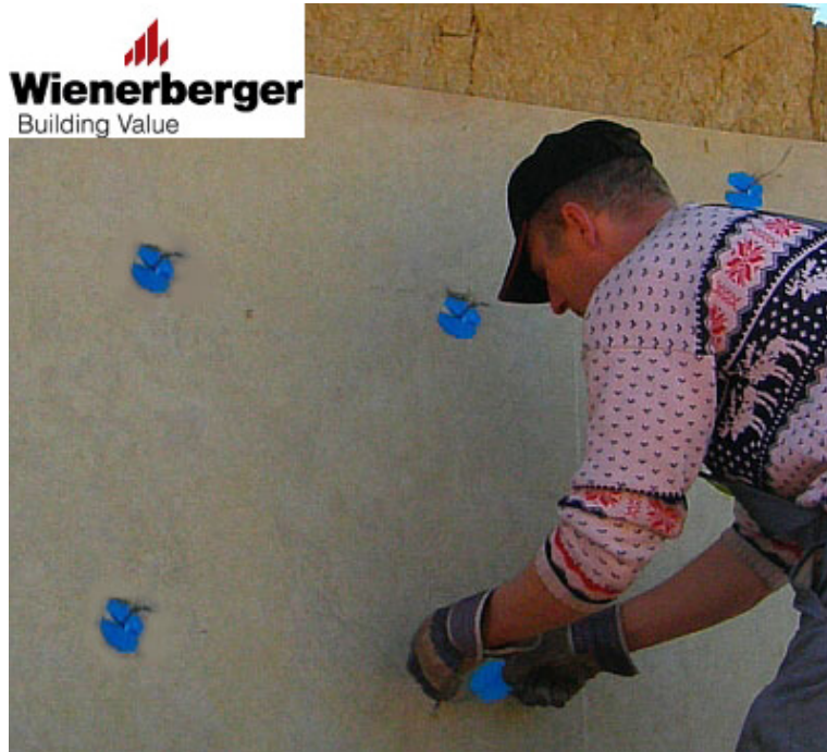
53 pav. Ant metalinių ryšių užmaunami apvalūs plastikiniai fiksatoriai
