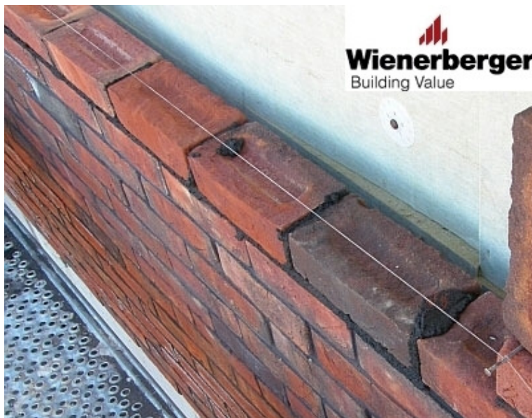
39 pav. Statybinės virvės ištiesimas per visą eilės ilgį
