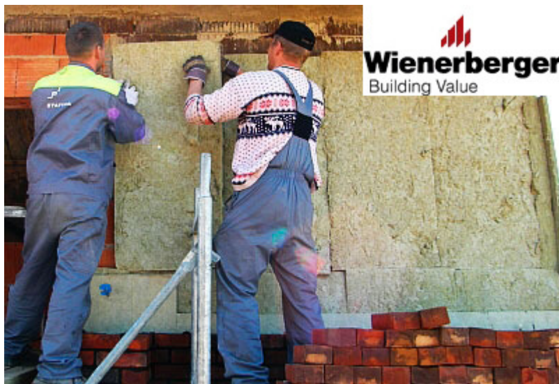
50 pav. Minkštų šiltinimo plokščių įrengimas
