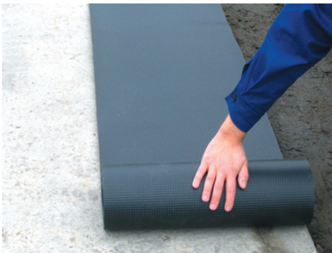
1 pav. Hidroizoliacijos įrengimas
