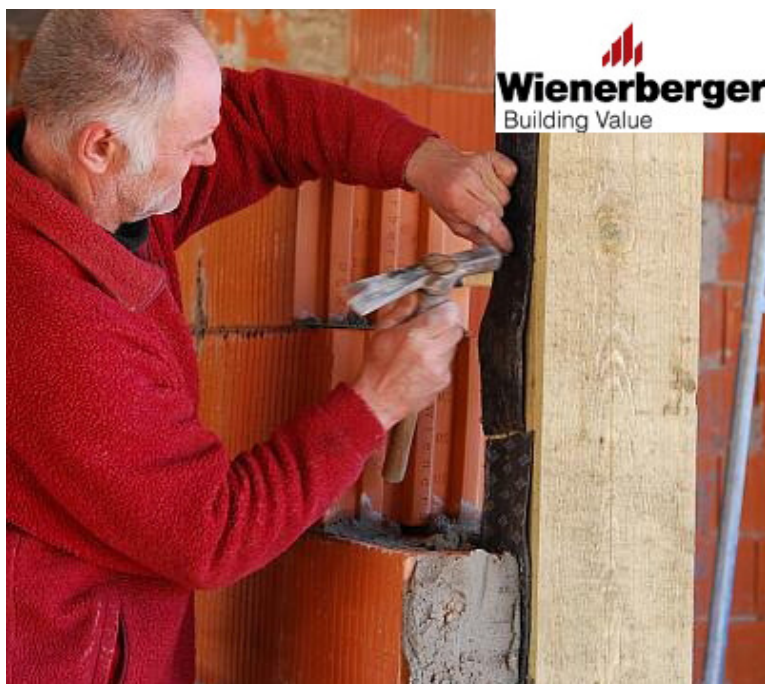
25 pav. Statramsčio apmušimas hidroizoliacine juosta
