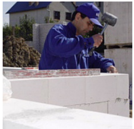
17 pav. Blokai išlyginami smūgiuojant guminiu plaktuku
