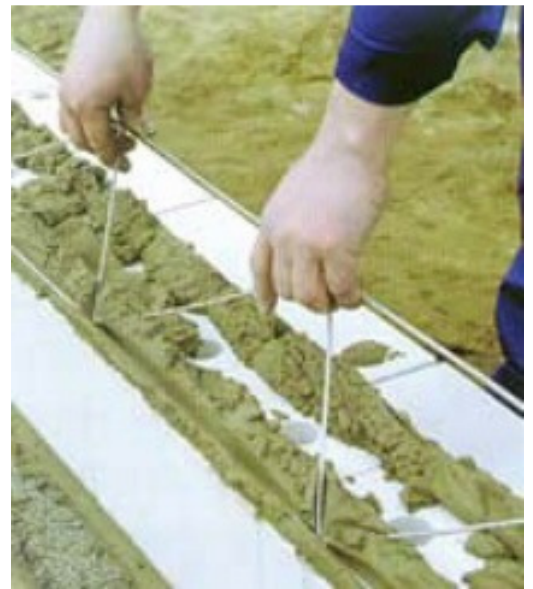
24 pav. Laikančios sienos armavimas
