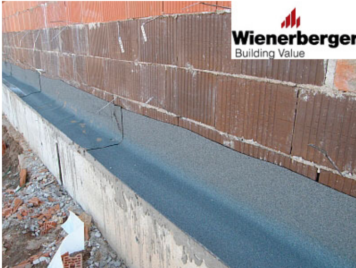
46 pav. Hidroizoliacinė juosta turi padengti ir blokų mūro, ir pamato paviršių
