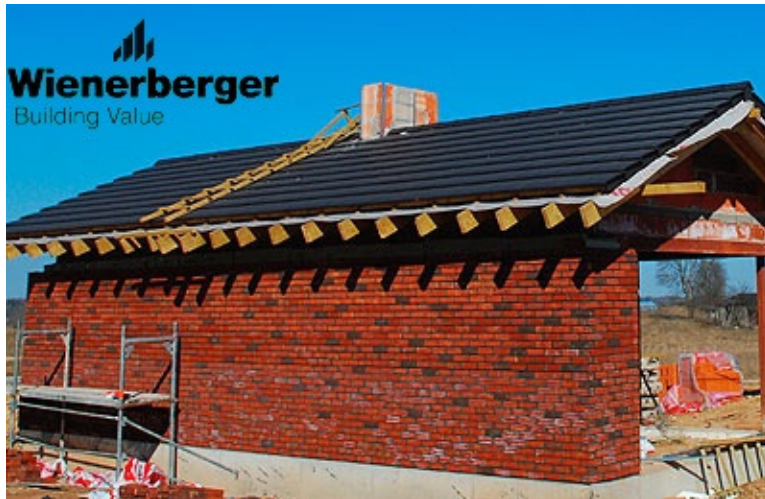
62 pav. Trisluoksnio mūro siena po apšiltinimo ir apdailinio mūrijimo darbų
