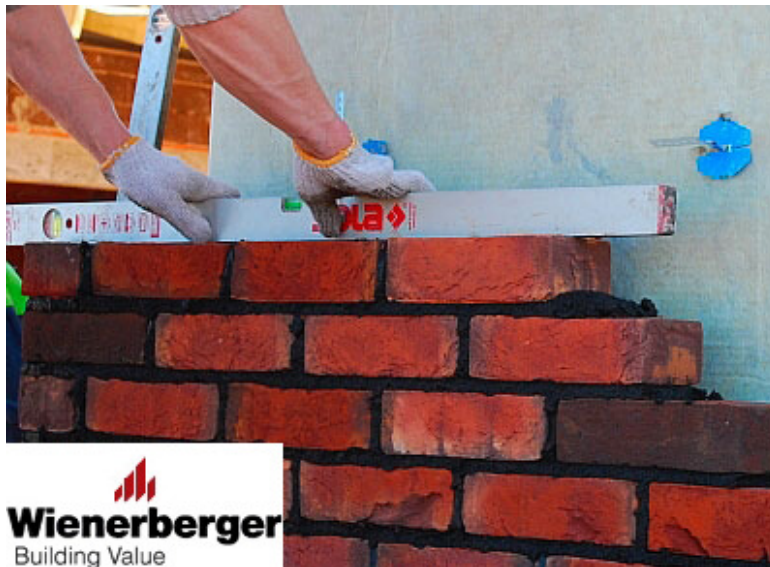
38 pav. Eilės horizontalumo tikrinimas gulsčiu
