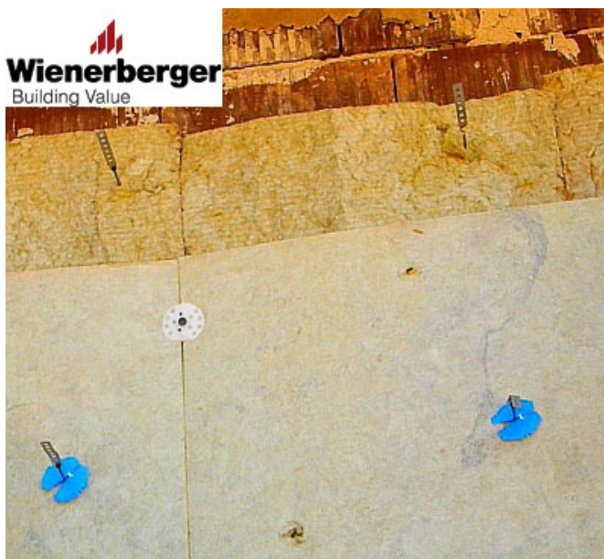
63 pav. Dėl priešvėjinės ir minkštos plokščių siūlių sutapimo prastėja sandarumas
