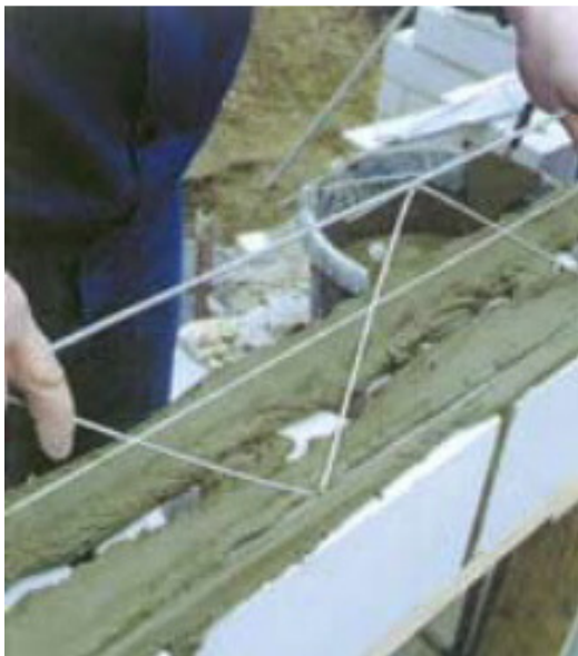
23 pav. Pirmos mūro eilės armavimas
