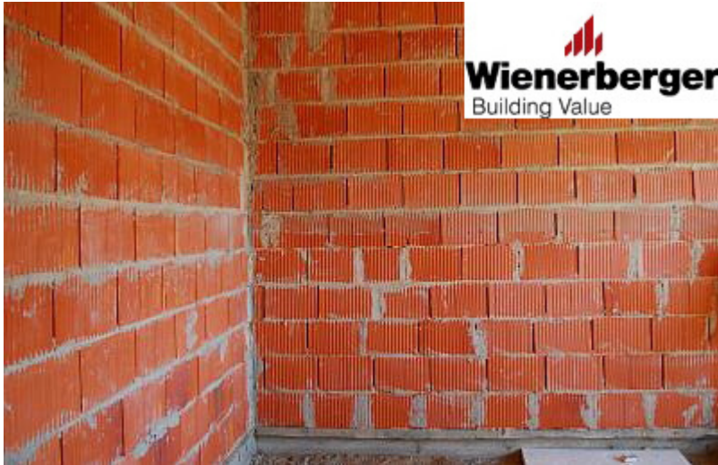
22 pav. Sumūryta keraminių blokų sienos kampas
