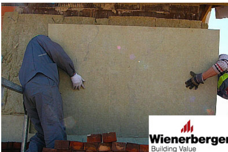
52 pav. Minkštas plokštes dengia kietesnės vėjo izoliacinės plokštės
