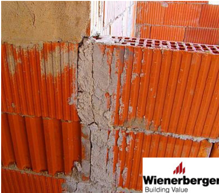
32 pav. Prastas skiedinys siūlėse pernelyg greitai išdžiūva ir pleišėja
