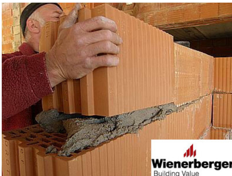
15 pav. Kiekvienas naujas blokas į skiedinį turi būti įstatomas tik iš viršaus
