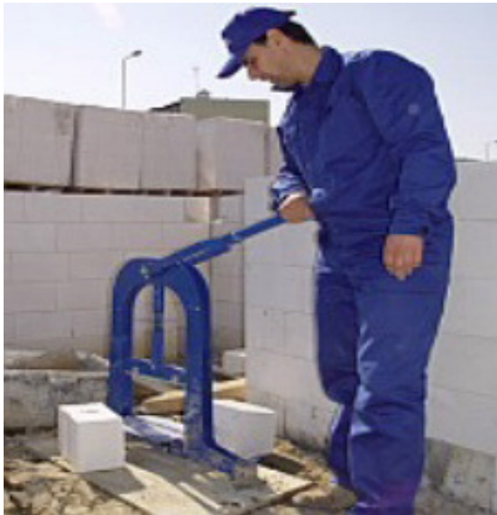
18 pav. Bloko pjaustymas
