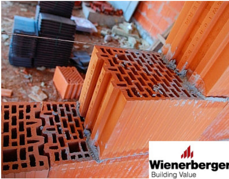
12 pav. Statybinės virvės ištempimas
