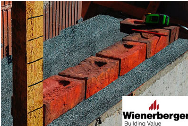
33 pav. Sausu būdu paklojus bandomąją plytų eilę, atžymų lentjuostėje fiksuojami būsimų eilių aukščiai bei skaičiuojamas reikalingas plytų kiekis eilei
