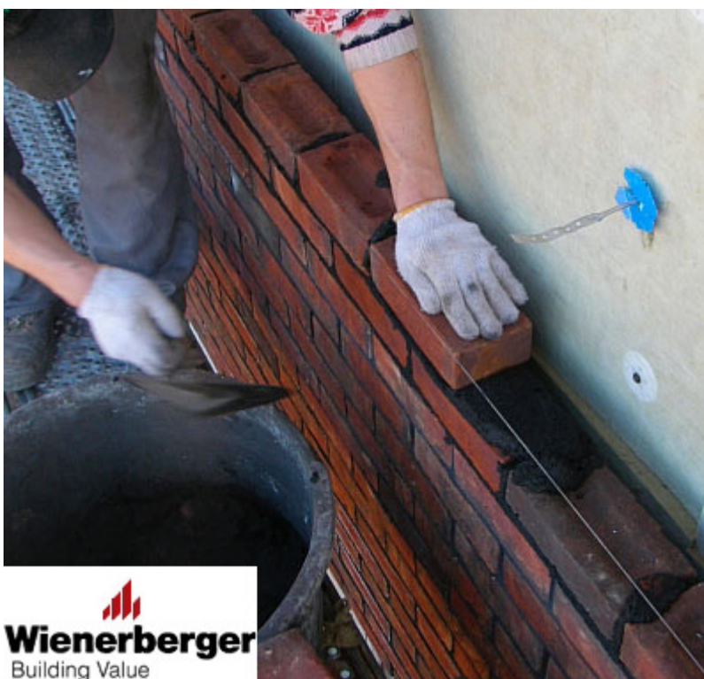
41 pav. Plyta skersgaliumi, padengta skiediniu prispaudžiama prie ankstesnės plytos
