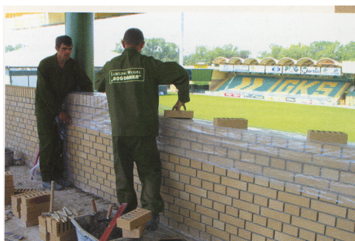
3 pav. Pertraukos metu išmūryta siena apdengiama plėvele.
