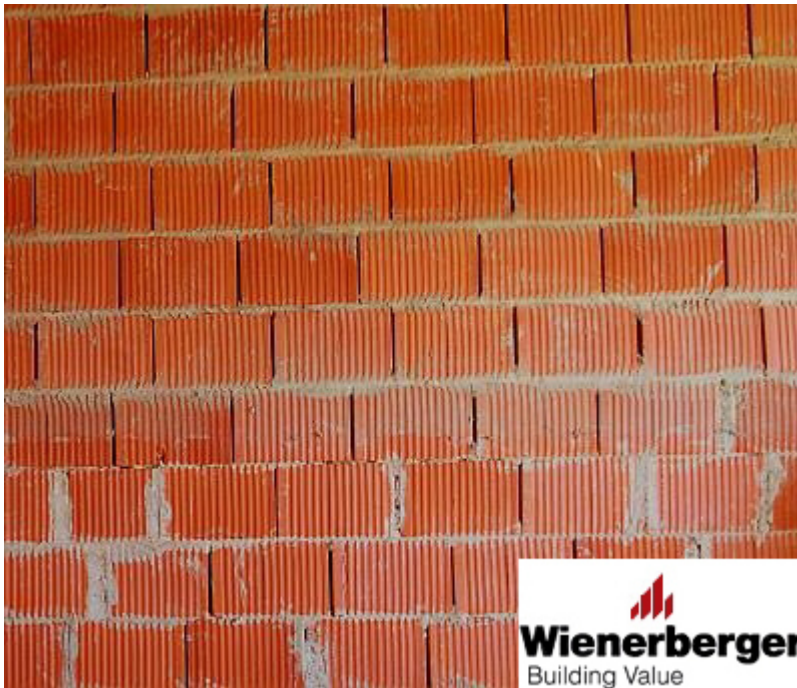
19 pav. Proporcingas vertikalų sujungimų pasislinkimas kitos eilės atžvilgiu - 95 mm.
