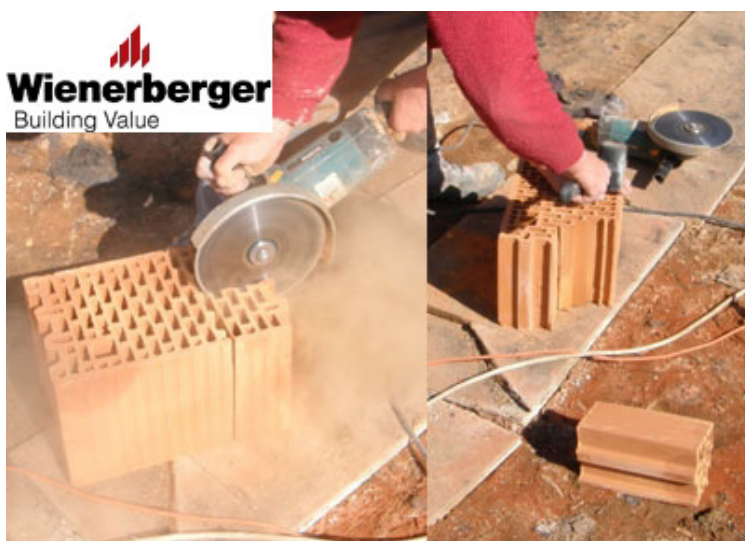
26 pav. Išpjaustomas bloko fragmentas
