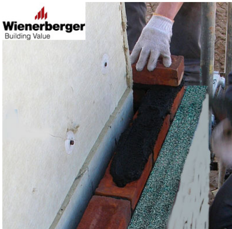
34 pav. Plytų eilę mūryti pradama nuo kampu
