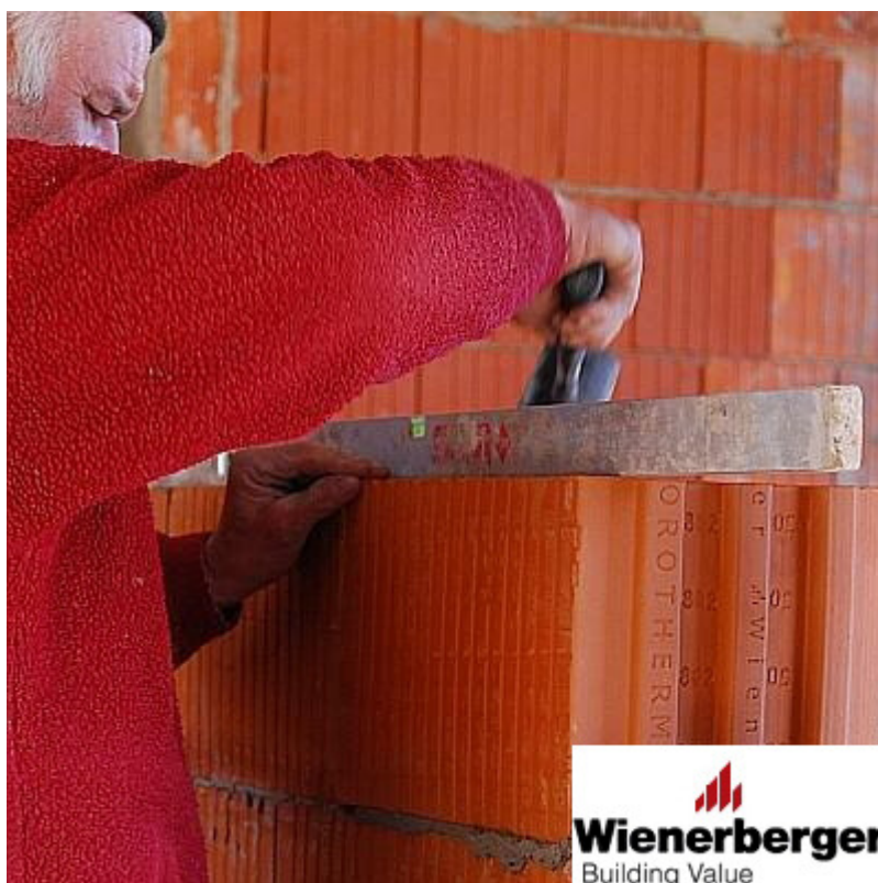
16 pav. Įstatyto bloko padėtis išlyginamas guminiu plaktuku
