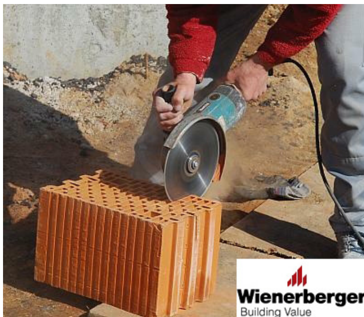
21 pav. Bloko pjaustymas
