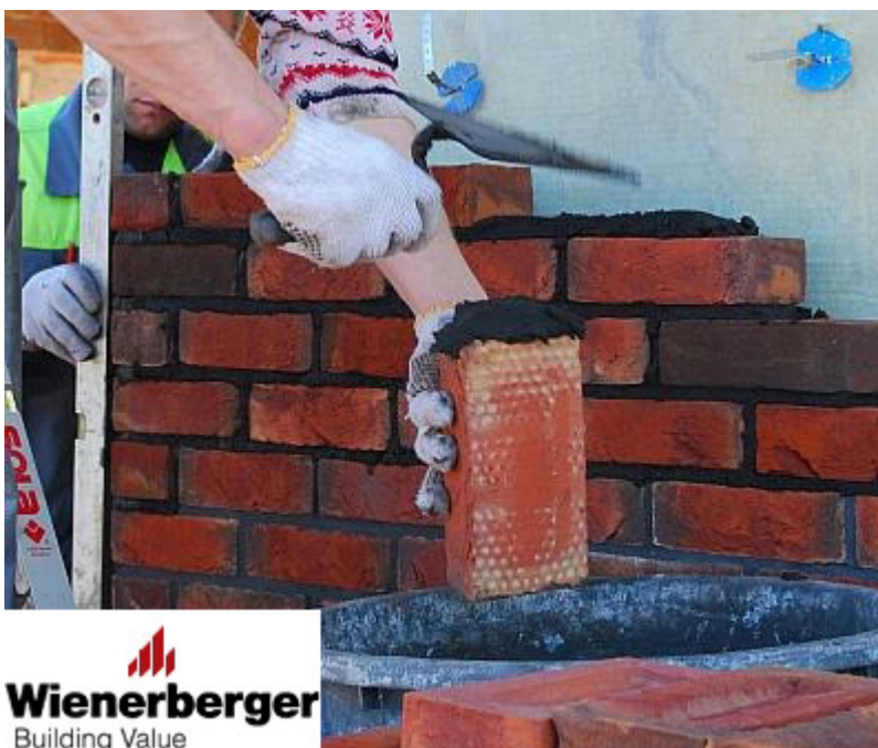
40 pav. Skiedinio klojimas ant naujos plytos skersgalio, mūrijant naują eilę
