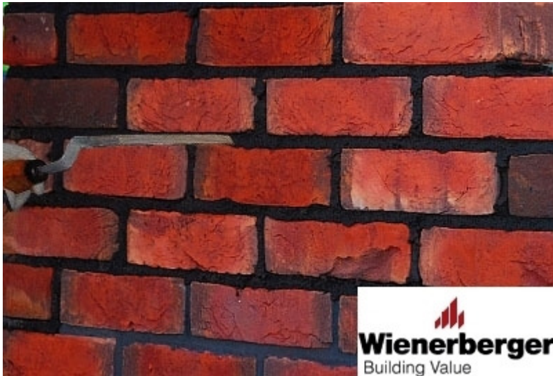
44 pav. Siūlių rievėjimas
