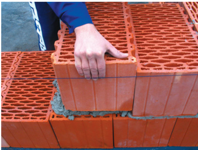
8 pav. Blokėlis įstatomas iš viršaus
