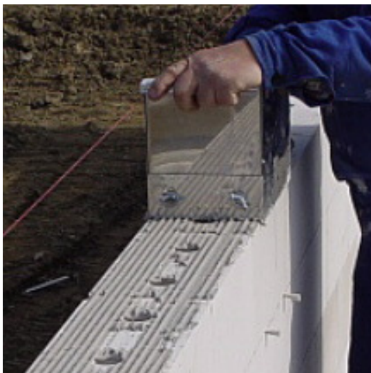
16 pav. Specialus dozatorius klijams lygiai paskleisti
