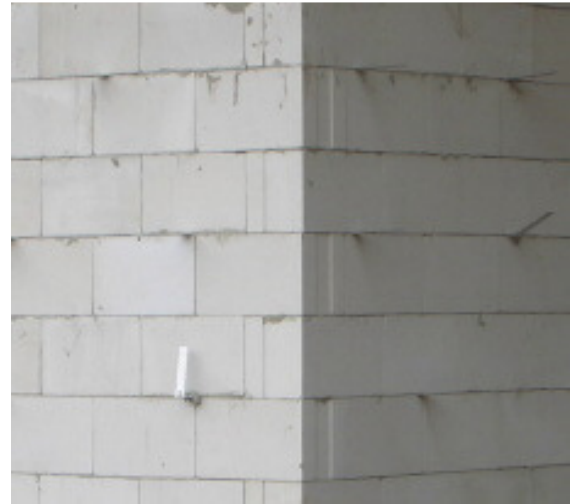
15 pav. Bloką perrišimas turi būti ne mažesnis kaip bloko plotis
