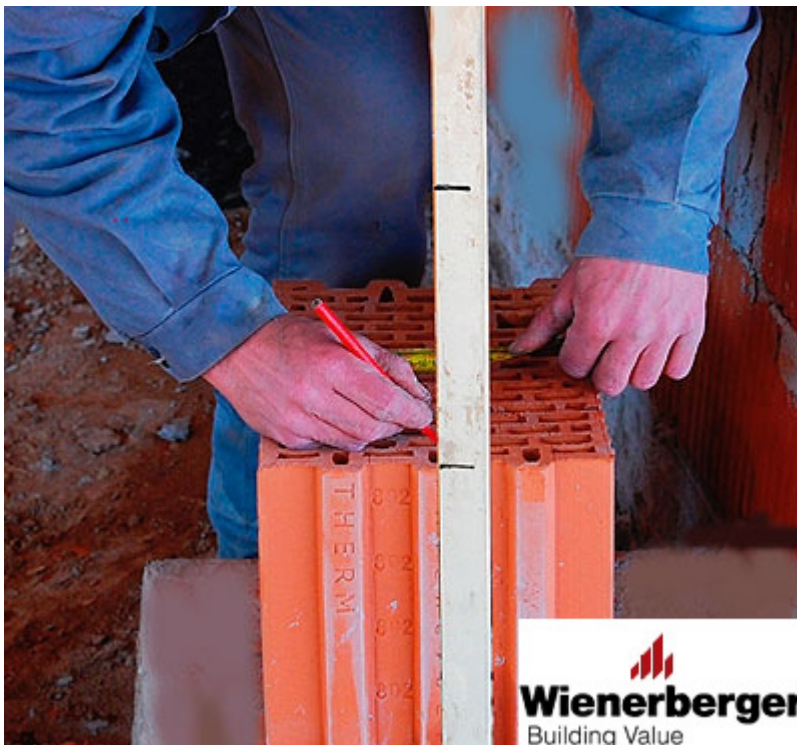
5 pav. Paruošiamieji lygių išmatavimai. Blokų aukščių atžymos lentjuostėje
