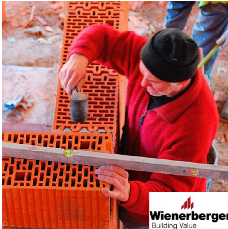
11 pav. Horizontalumo tikrinimas gulsčiu ir bloko koregavimas guminiu plaktuku
