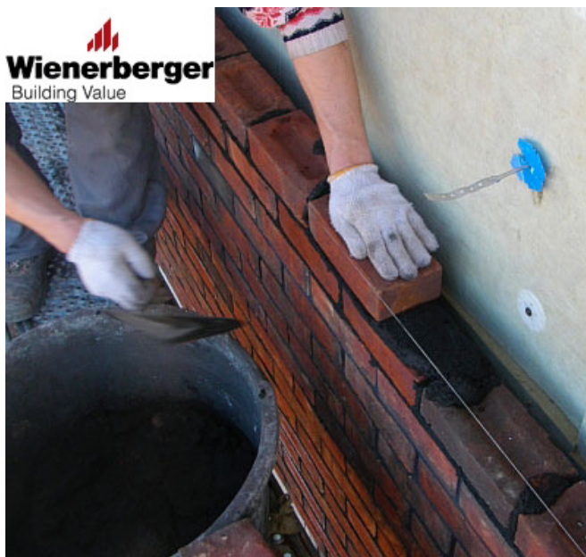
59 pav. Plytų padengtų skiediniu ir sujungiamos su kitomis tradiciškai
