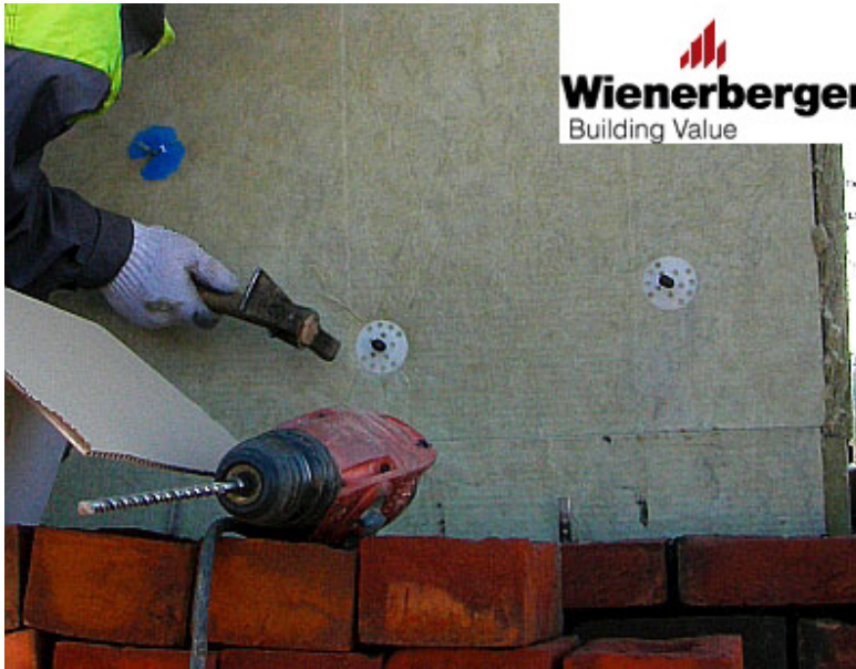
55 pav. Į pragręžtas angas įstatomos 20-25 cm smeigės ir plaktuku išmeigiamos iki galo
